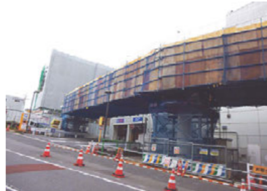
医療ビルに直結する工事の歩行者デッキ
