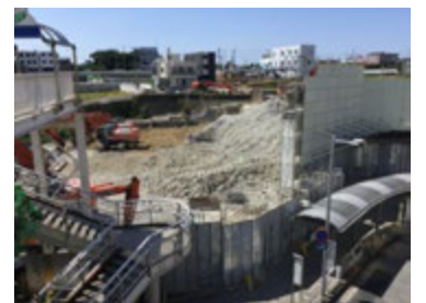
解体進む取手駅西口前のビル群(6月7日撮影)
