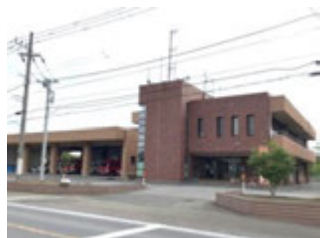
建築後36年が経過、大規模改造される櫛木消防署
