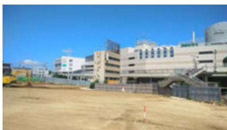
一棟残り工事中のA街区(暫定駅前広場)=7月19日撮影
