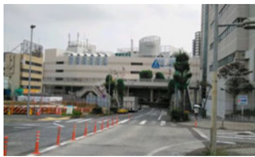
間もなく第1期整備工事が始まるペデストリアンデッキと取手駅西口全景（国道6号方面から）
