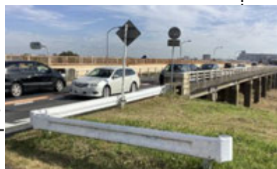
整備が急がれる旧6号国道文巻橋
