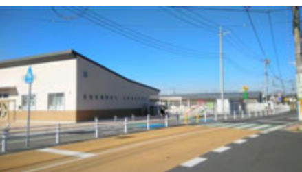
井野なないろ地域子育て支援センター（後方はなないろ保育所）
