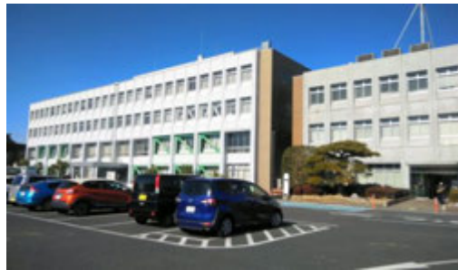
取手市役所庁舎
