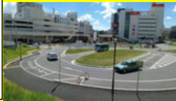
取手駅西口仮設交通広場（10月2日撮影）
