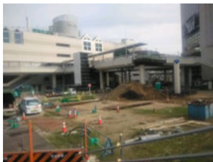
工事中の取手駅西口交通広場、右奥にリボンビル左側に駅ビル(10月2日)
