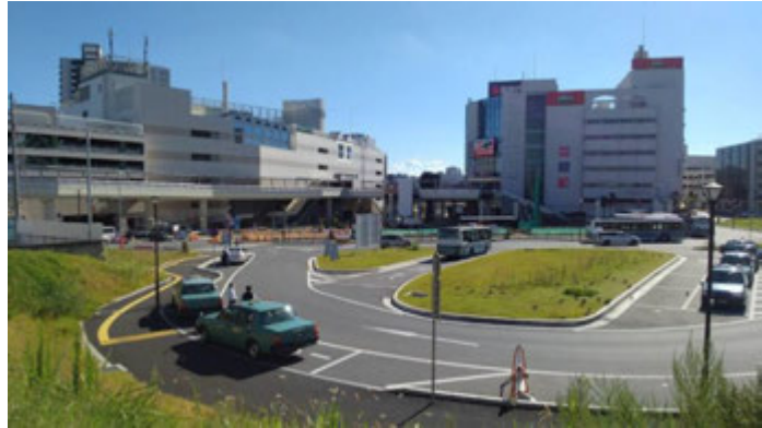
現在の取手駅西口仮設交通広場（A街区再開発事業予定地） 奥に工事中の駅前交通広場（左にアトレ、右にリボン取手） 10月31日撮影
