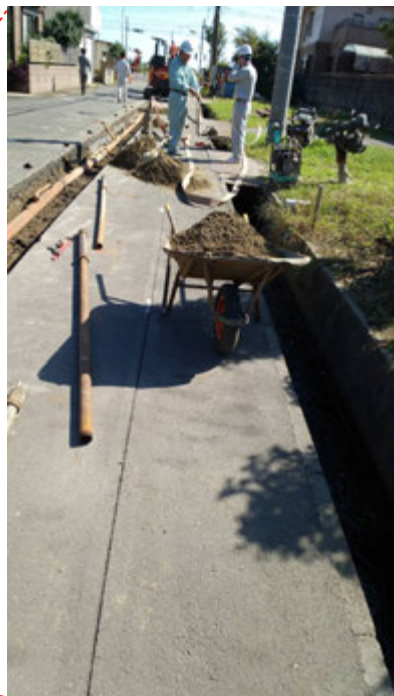
排水路の一時移設へ排水溝設置工事中の現場 (10月13日撮影)
