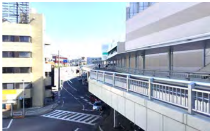
取手駅西口 Boxヒル、歩行者デッキ
