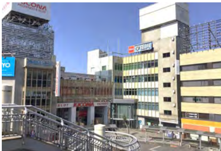
取手駅西口 解体予定ビル群
