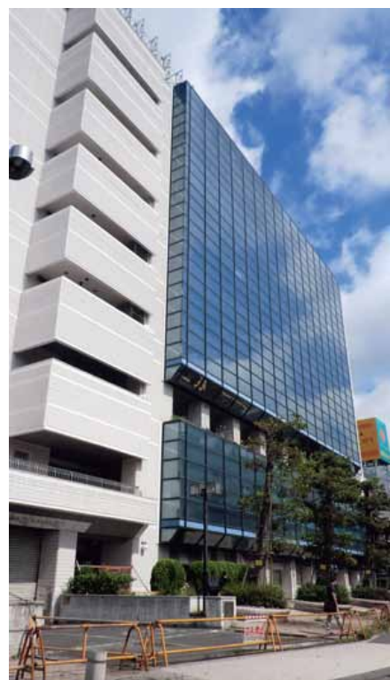
空きビルのままの「旧東急ビル」 (2012.7.3撮影)
