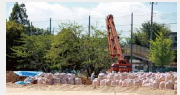
戸頭中/除染工事中(8月21日撮影)
