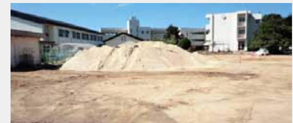
永山中/除染工事中(8月21日撮影)
