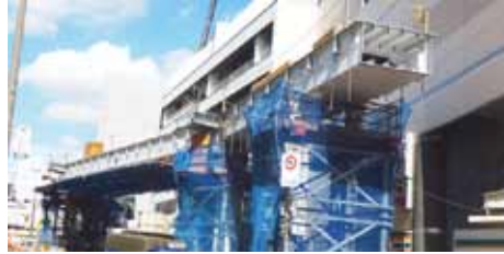
▲「医療ビル」につなぐ歩行者デッキ建設中（市施工…建設事業費7.7億円）
