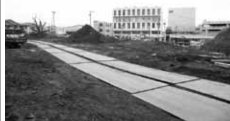
ウェルネスプラザ建設予定地 (B街区・県学生寮跡地) 1月25日撮影
