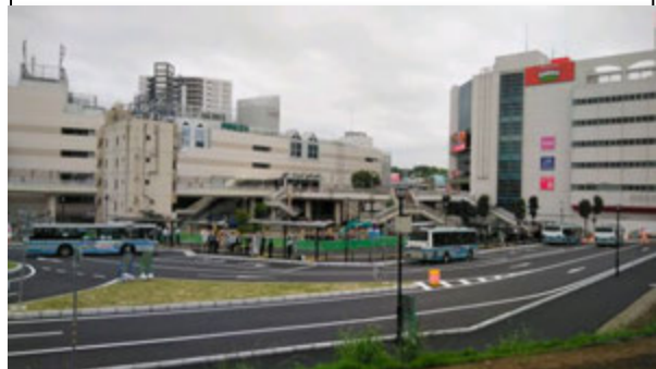
仮設広場の角に残されたビル。市の不公正な進め方が地権者の同意の妨げに。
