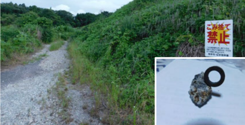
米の井の土砂崩れが心配な残土の山
