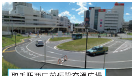
取手駅西口前仮設交通広場
