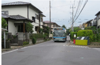
西1-35付近 (バスの奥に向かって)今年度工事
